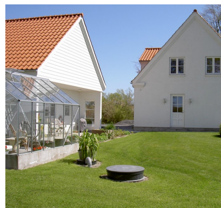
Pluto BDT installerat vid ett enfamiljshus
